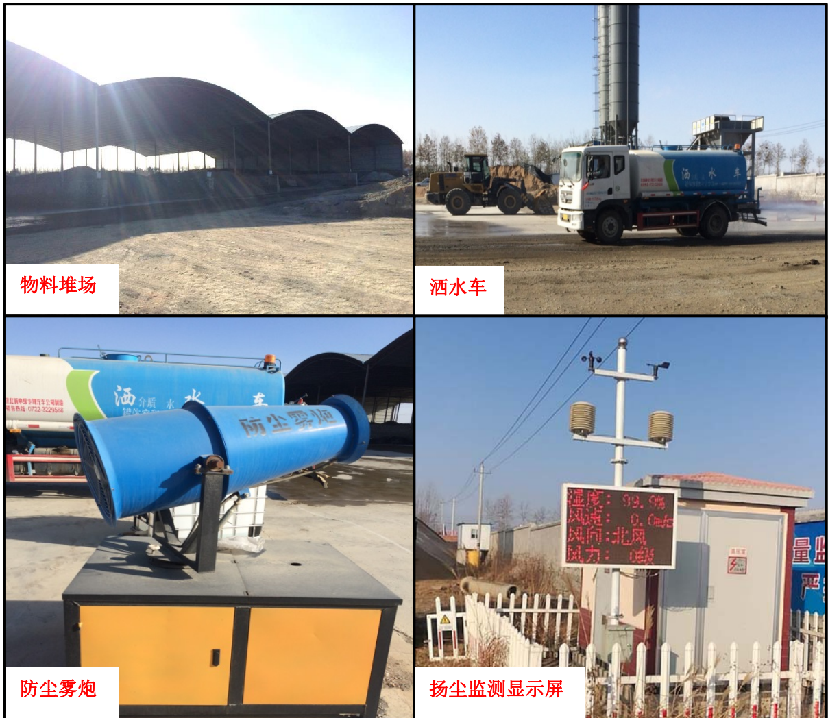
图 2-8 扬尘防治措施实景
