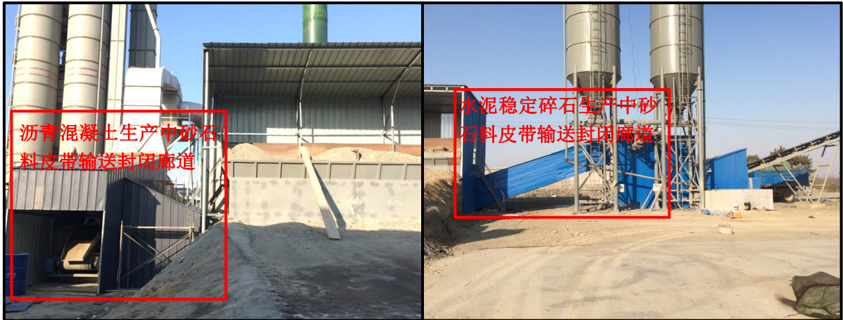
图 2-6 皮带输送封闭廊道实景
